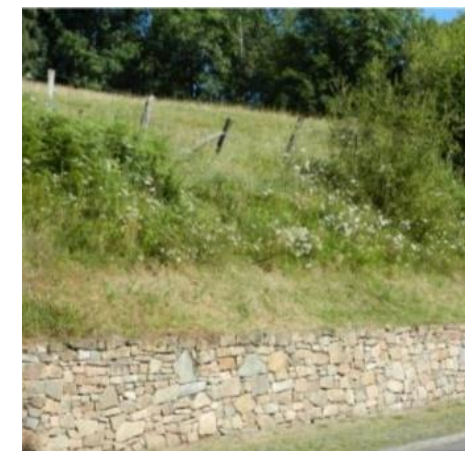
Mur de soutènement et talus
