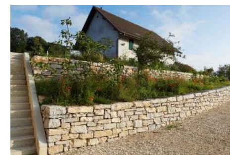
Mur de soutènement en paliers
