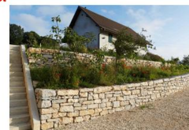
Mur de soutènement en paliers
