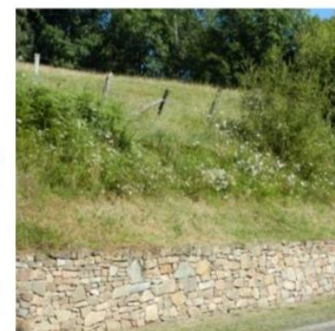
Mur de soutènement et talus
