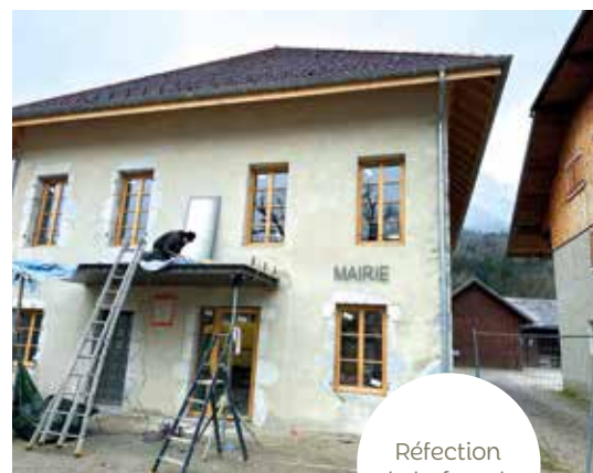
Façade enduit à la chaux
