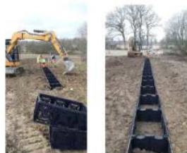
Figure 4: Installation d'une rangée d'échelles d'eau dans un jardin privé. Le long de la clôture - source : http://www.ferme-engagnes.com/municipalite-commune-de-alex/formation-technique-2-25-01-2015-01.pdf
