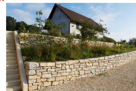
Mur de soutènement en paliers
