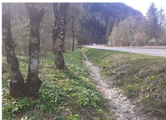
Tronçon Sud de la chaussée
