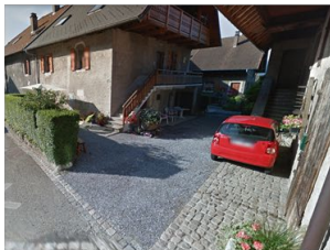
Simplicité des aménagements et homogénéité des matériaux.
