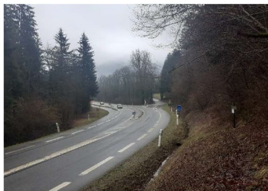
Virage à l'extrémité Ouest du tronçon
