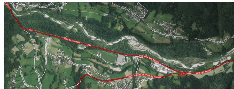
Le torrent du Fier, une coulée "verte et bleue", longée par les axes routiers structurants
