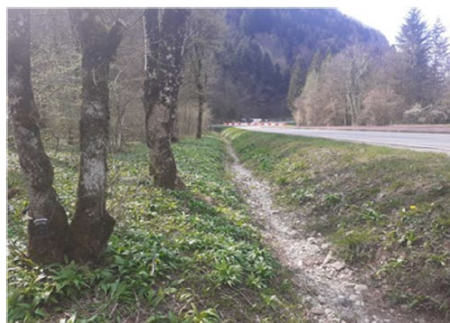
Tronçon Sud de la chaussée
