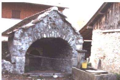
Four banal des Villards-Dessous : L'avancée est typique des fours les plus anciens (17 ème et 18 ème siècles).
