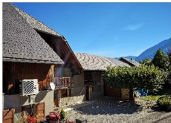
Aux abords de l'Eglise, une cour aménagée avec simplicité, contribuant à la mise en valeur du patrimoine bâti.
