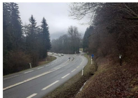
Virage à l'extrémité Ouest du tronçon
